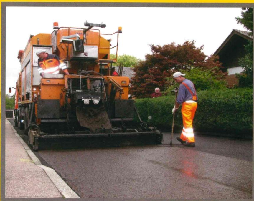
Durch die Versiegelung mit dem VSI Dünnschichtverfahren wird die Nutzungsdauer um Jahre verlängert.
