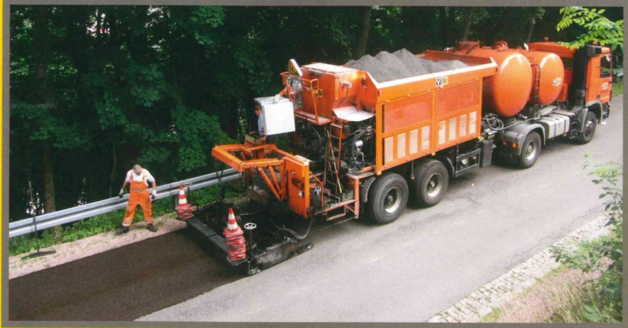
Das, speziell auf die Erfordernisse der Unterlage abgestimmte Mischgut wird in selbstfahrenden Arbeits- und Mischmaschinen gemischt.
