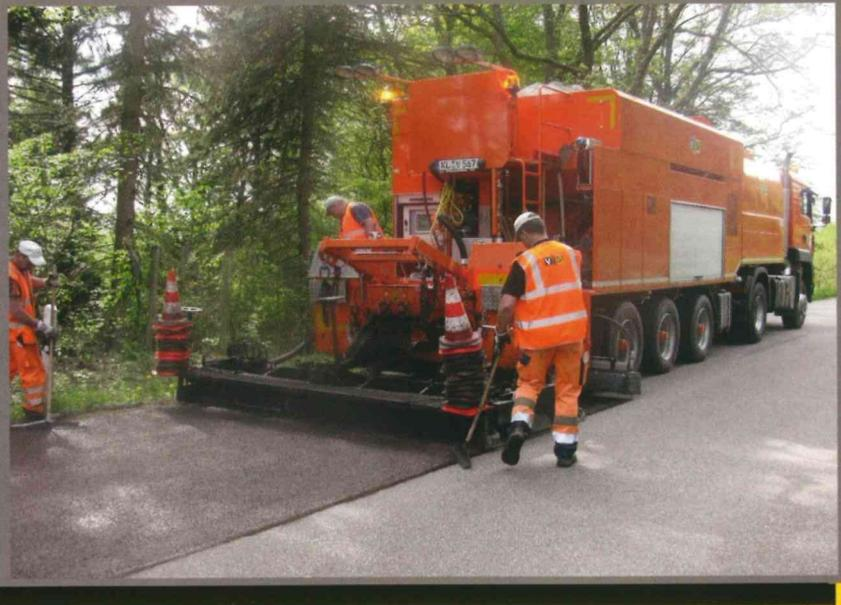
Der Einbau erfolgt in der Regel halbseitig mit einer variablen Bohle.
