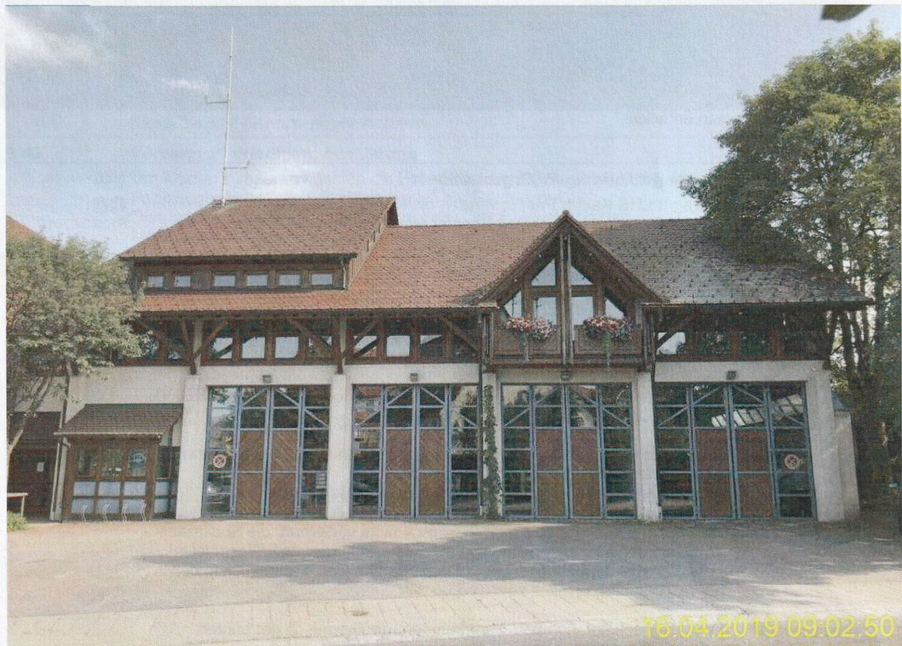
Die bestehenden Falttore könnten durch neue thermisch getrennte Sektionaltore ersetzt werden.
