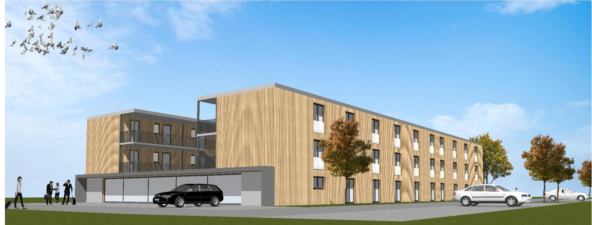
**Bauweise: Holzhybridbau / schnelle Bauweise durch großen Vorfertigungsgrad**
