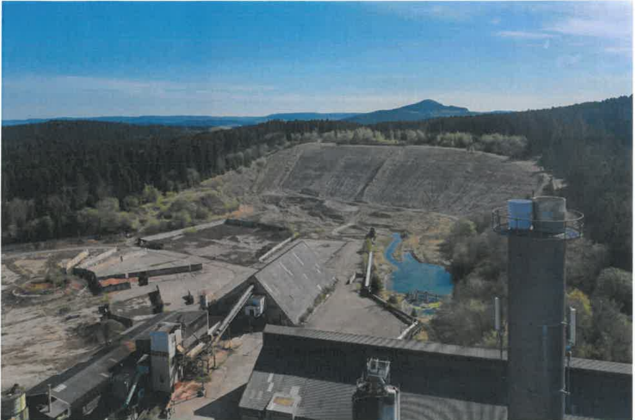
Abbildung 3: Blick von Westen über die Grube. In der rechten Bildhälfte das große Gewässer am Südrand (Fläche 14). Bild vom 16.4.2020.
