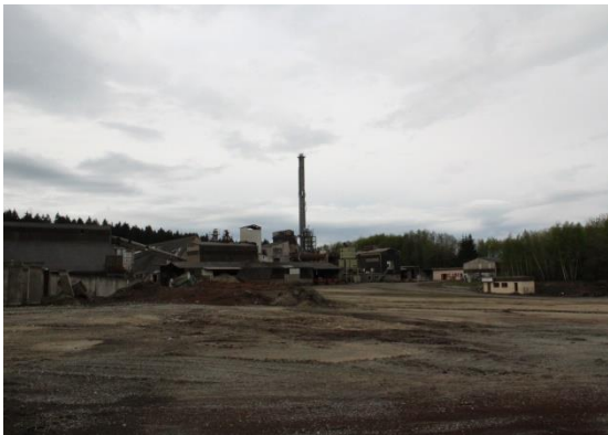
Blick nach Südwesten auf die Schornsteinanlage (Altlast)
