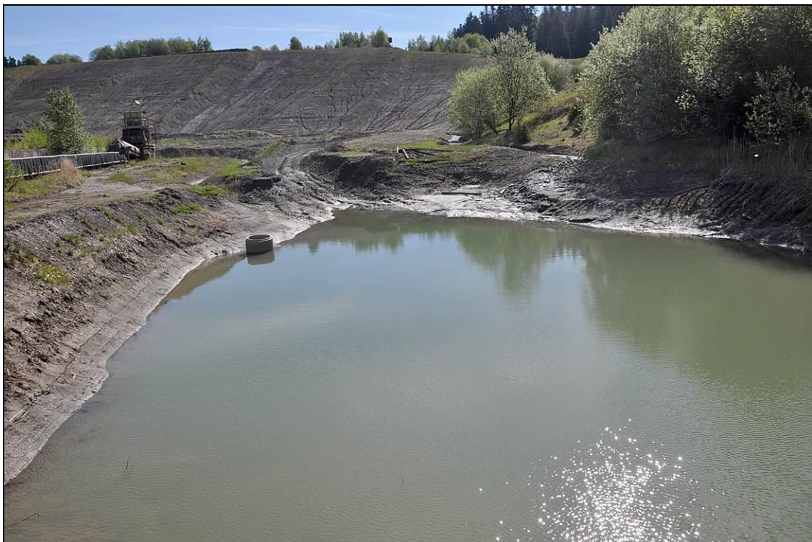
Foto 10: Das größte Gewässer in der Grube, ein technisches Becken im südwestlichen Teil (Gewässer 1), nach der vollständigen Ausräumung im Winter 2013/14. 5.5.2014.
