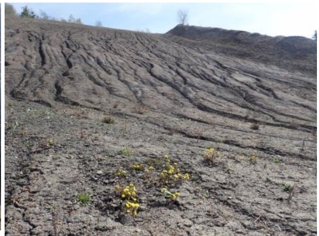
Von dem Vorhaben betroffene Rohböden mit Pionier- und Ruderalvegetation.
